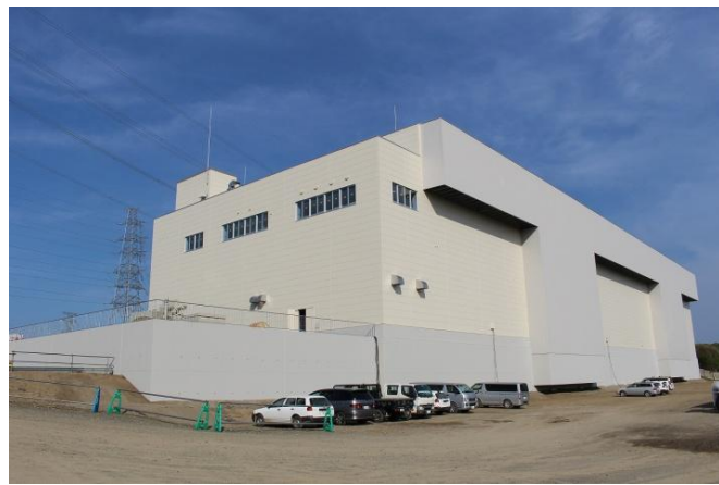
<蓄電池建屋外観>
