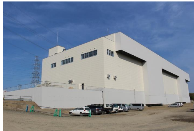
<蓄電池建屋外観>
