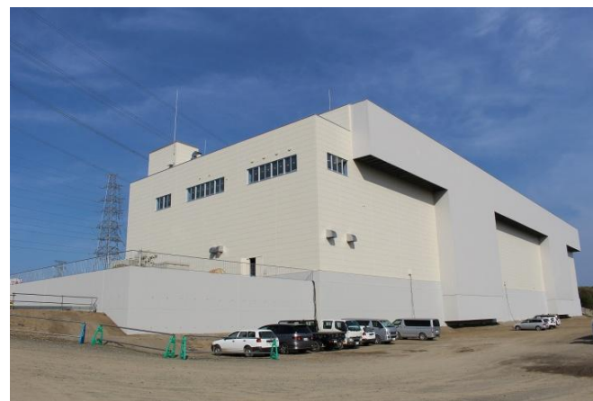
<蓄電池建屋外観>
