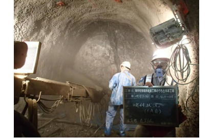
吹付け試験状況
