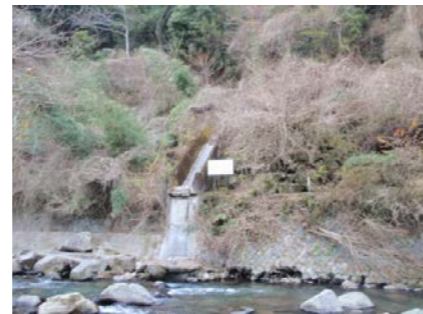
余水路末端部
