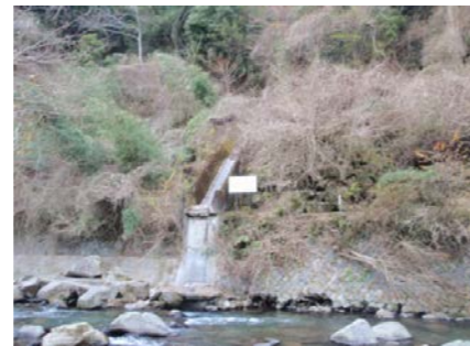
余水路末端部
