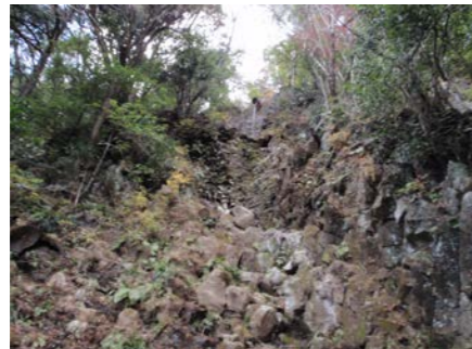
余水路岩盤露頭
