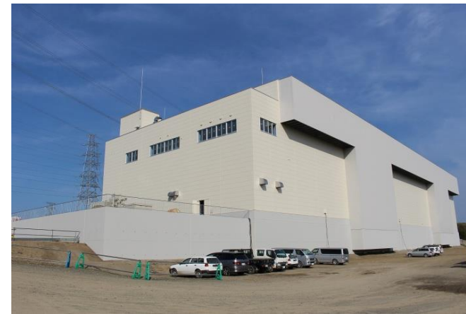
<蓄電池建屋外観>
