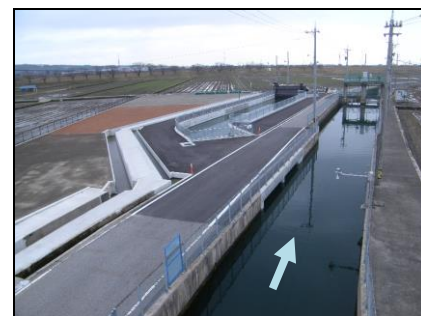
黒東合口用水からの取水口
